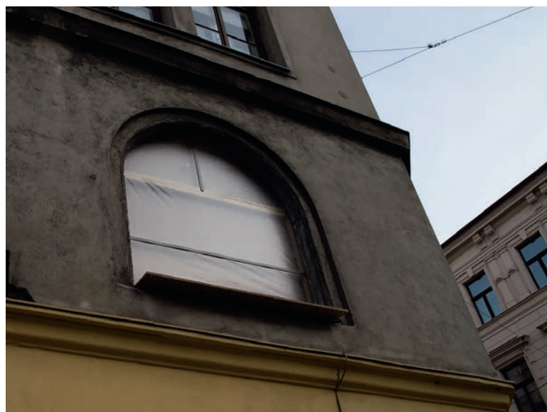
Die Fensteröffnungen sind mittlerweile wind- und regendicht verschlossen.
