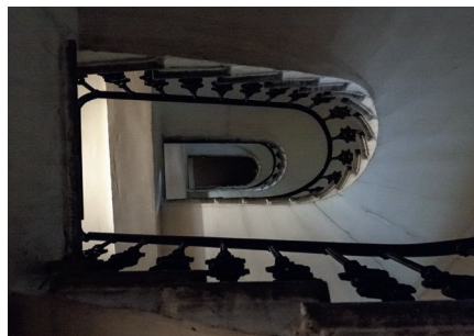
Blick ins intakte Stiegenhaus.
