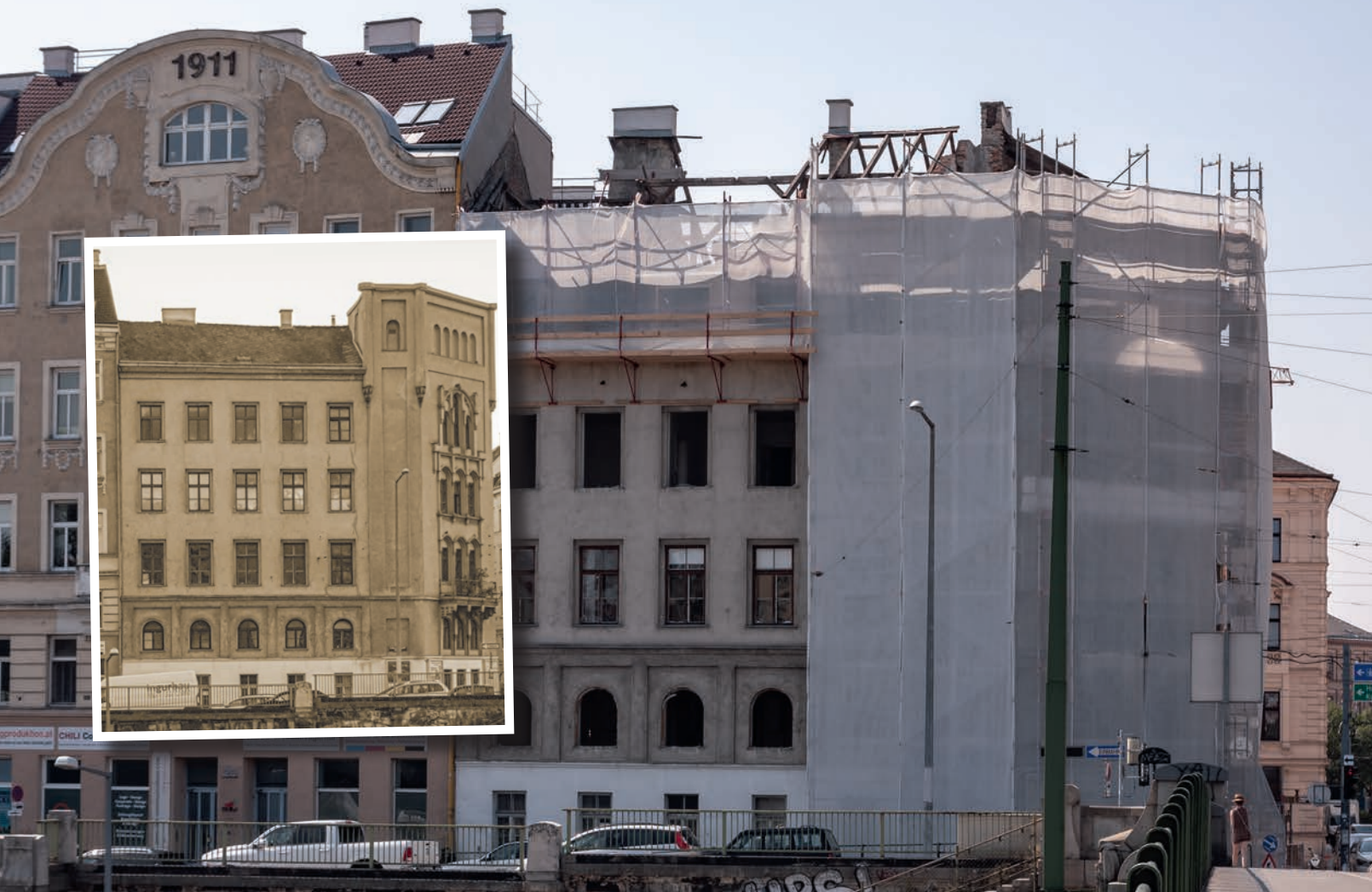
Vorher – Nachher: Der weithin sichtbare, dem Donaukanal zugewandte Eckturm (kl. Bild) wurde demoliert, das Dach des Hauses abgetragen.
